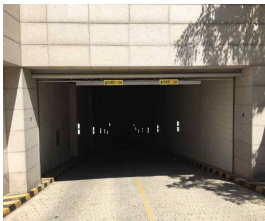
광개토관 지하주차장 입구[통과 높이 2.7m]
