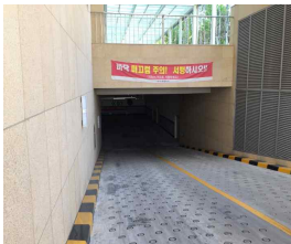
대양AI 지하주차장 입구[통과 높이 3.0m]
